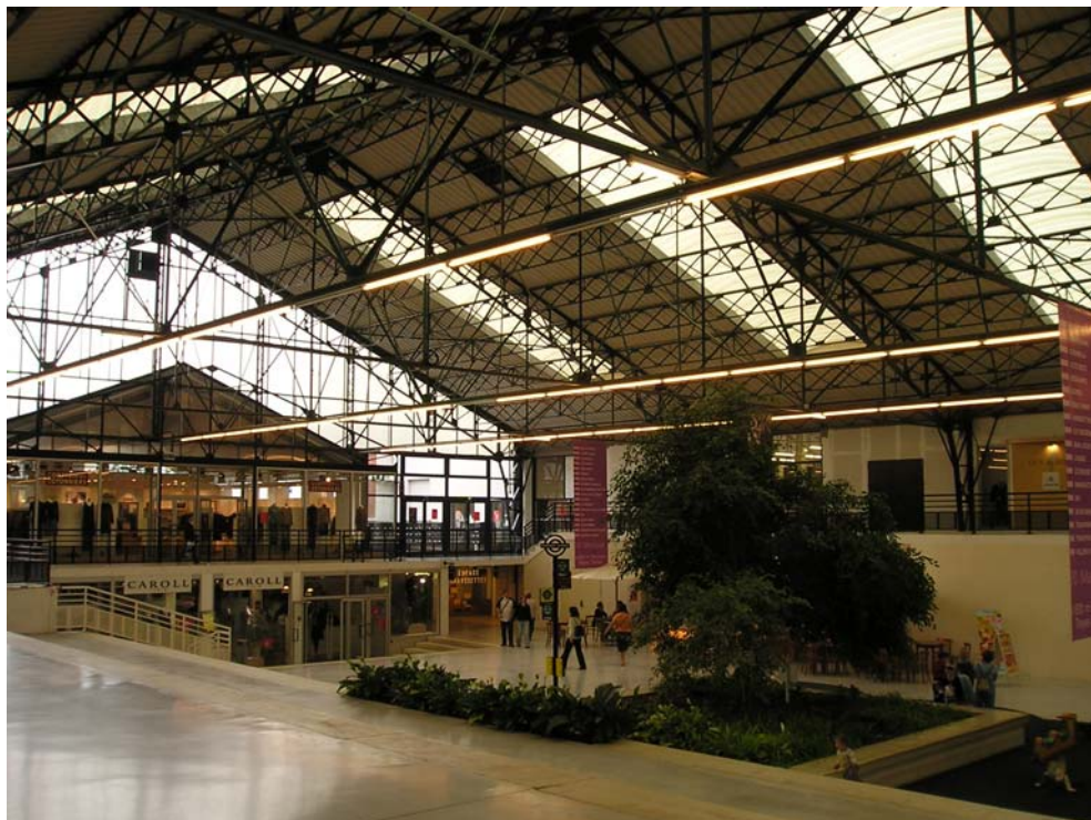
L'intérieur du bâtiment 1 du centre « Marques Avenue » de Troyes (photographie : C. Lamy, septembre 2005)
