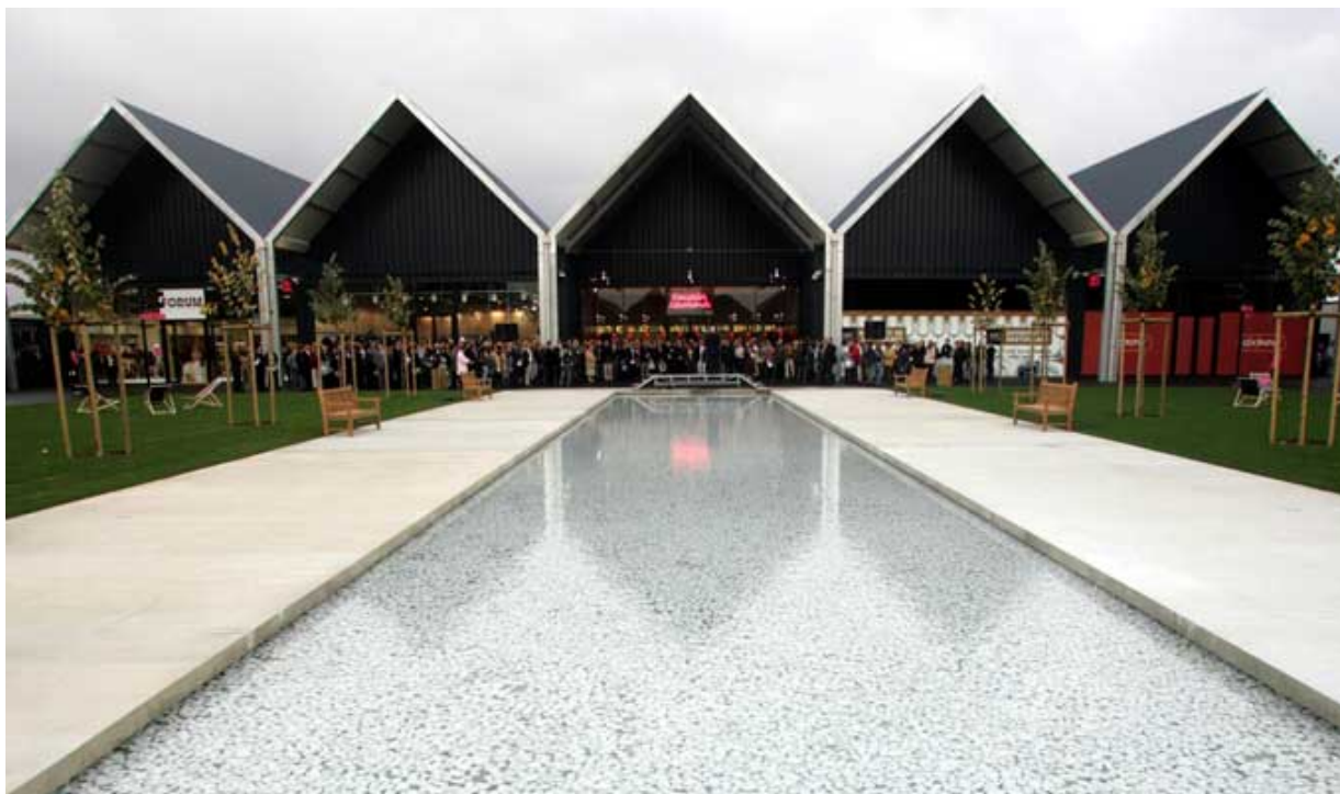
Le centre « Marques Avenue » de La Séguinière (agglomération choletaise) (photographie tirée du site Internet www.wilmotte.fr )
