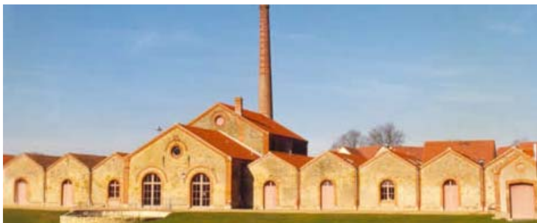
L'ancienne blanchisserie de la Rivière Sauvageau réhabilitée en musée du Textile (photographie : museedutextile.com )
